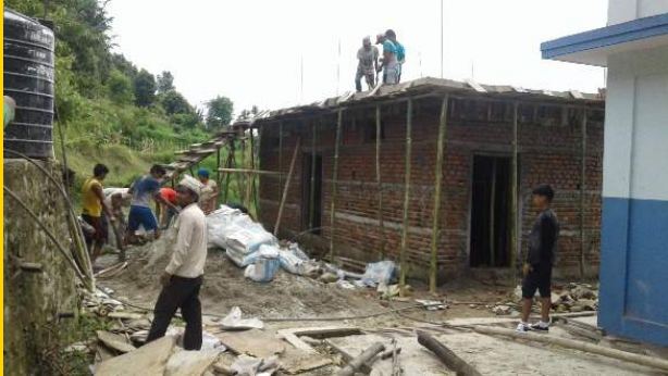
Nieuw toiletgebouw en betere hygiëne voor een middelbare school in Harmi
