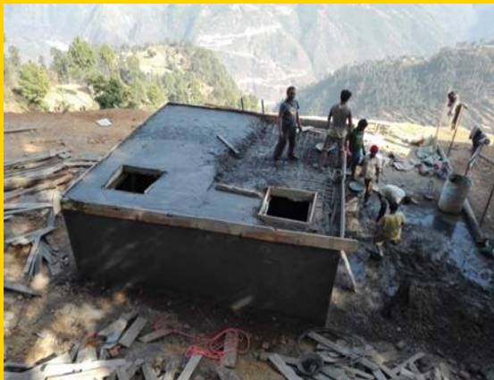
Bouw van de regenwateropslagtank bij de medische post van Dolalghat, Kavre district
